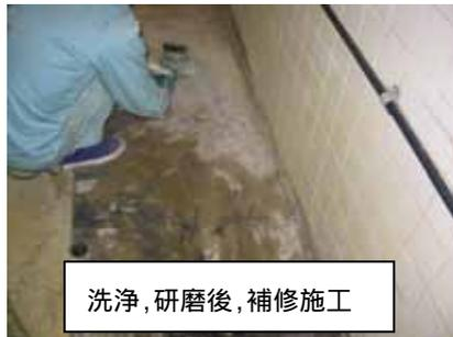
洗浄, 研磨後, 補修施工
