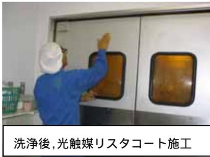
洗浄後, 光触媒リスタコート施工
